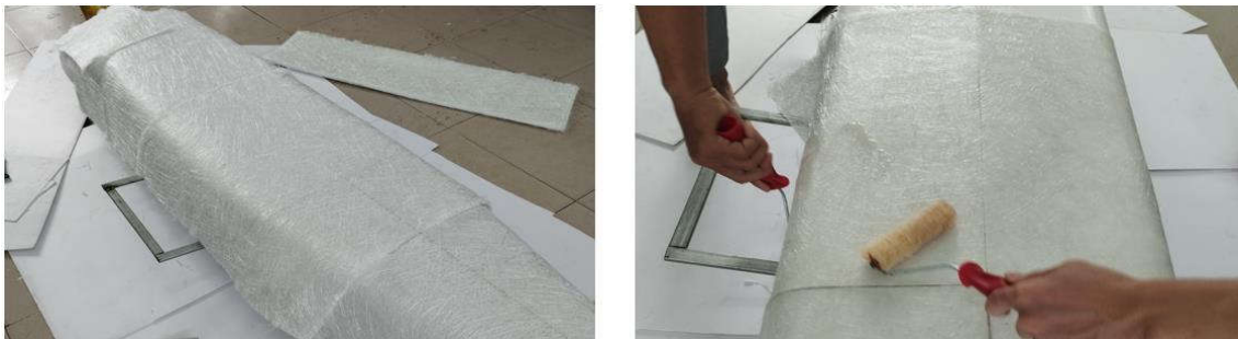
Hình 6.16 Quét keo, trải sợi thủy tinh mặt ngoài
