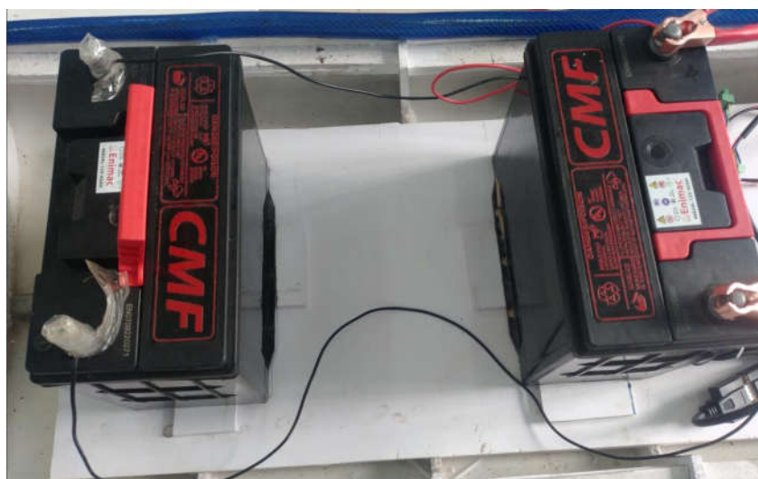
Hình 7.7 Lắp ắc quy
