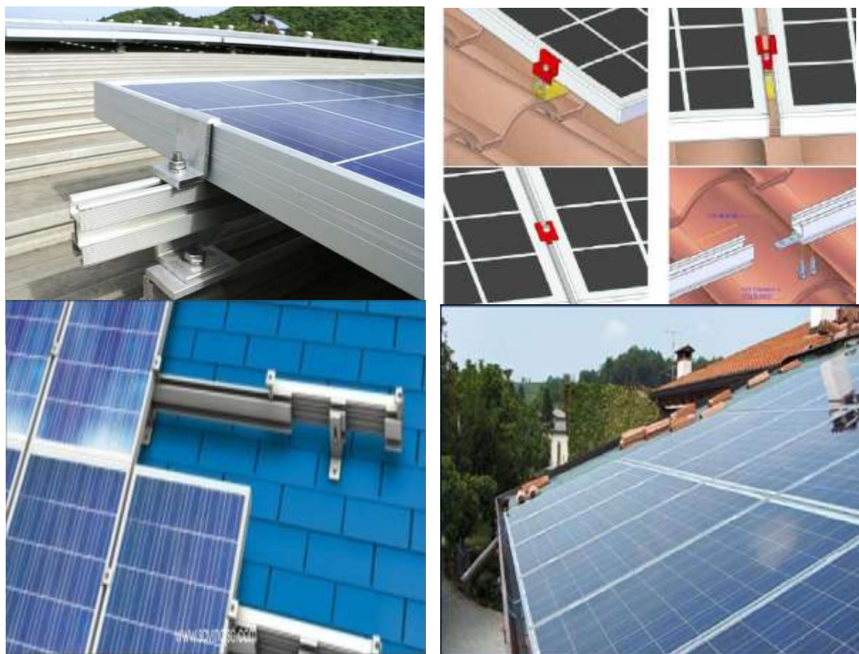
Hình 5.12: Lắp đặt pin năng lượng mặt trời
