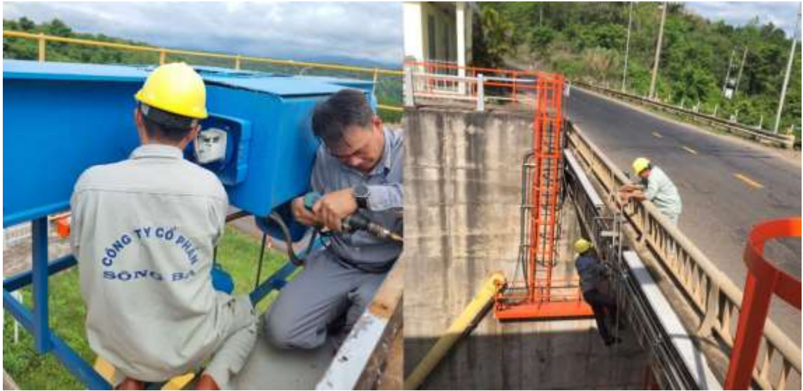
Hình 5.2 Công nhân NMTĐ thực hiện bảo trì, bảo dưỡng tại đập tràn
