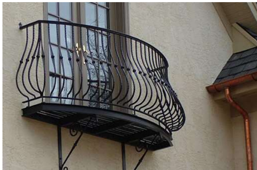
Hình 1.15 – Uốn lan can tạo hình
