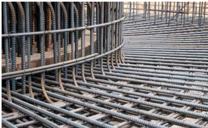
Hình 1.13 - Ứng dụng uốn thép trong xây dựng
