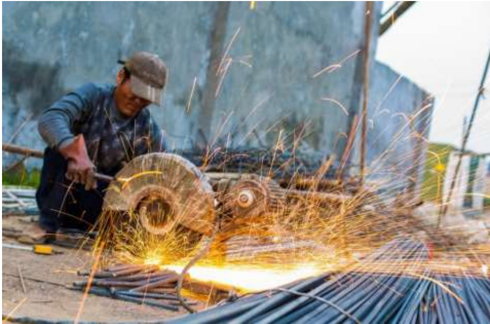
Hình 1.7 – Cắt thép trong xây dựng
