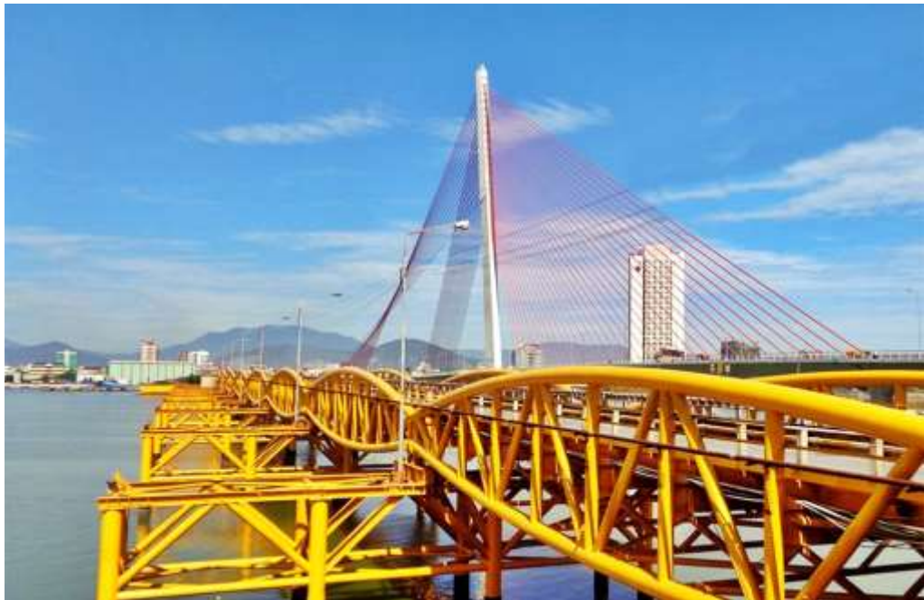
Hình 1.4. Cầu Nguyễn Văn Trỗi ở Đà Nẵng sử dụng nhiều ống thép
