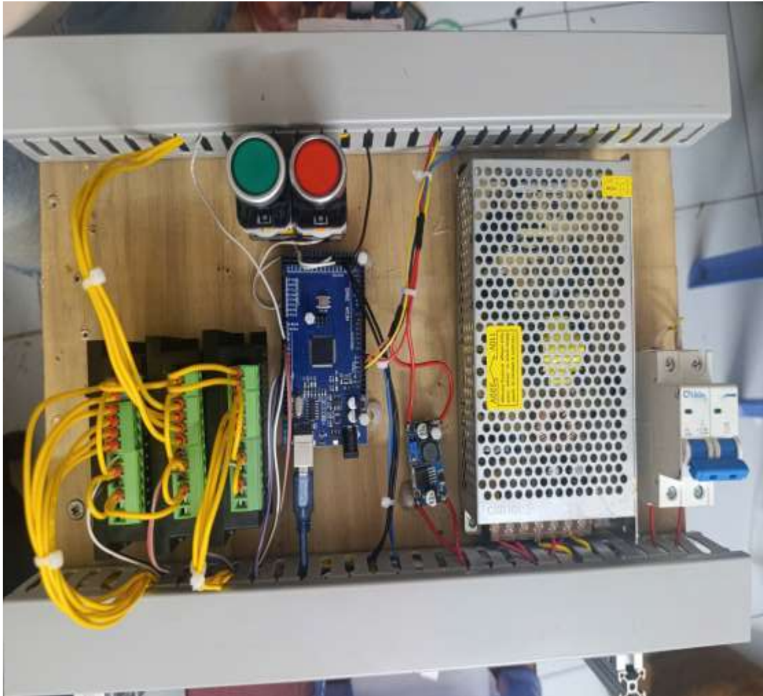
Hình 2.16 Hệ thống điện sau khi hoàn tất đấu nối
