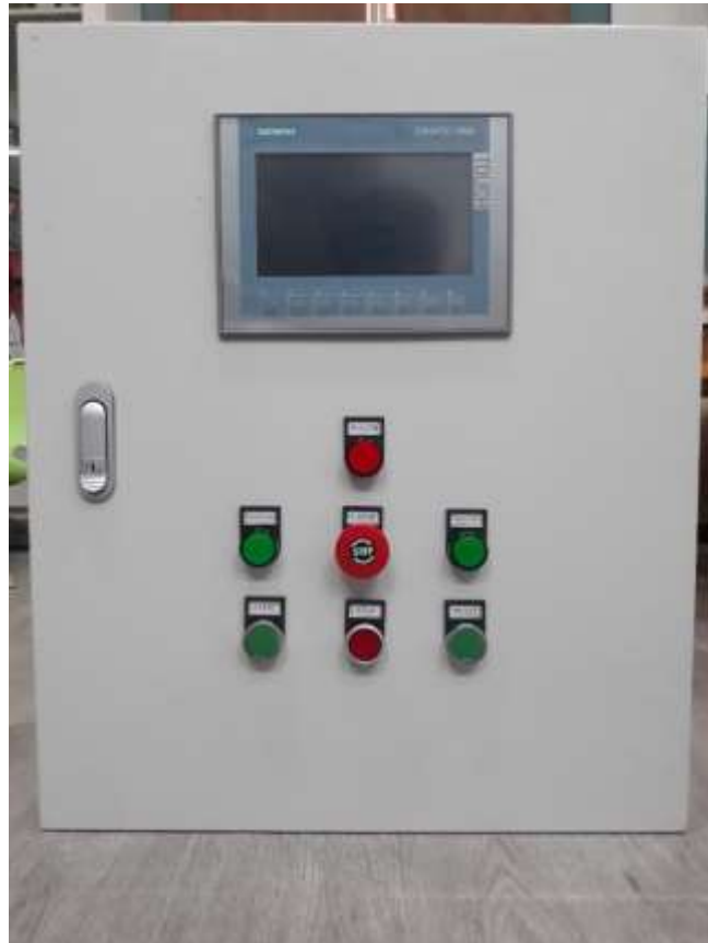
Hình 4.5 Tủ sau khi hoàn thiện.
