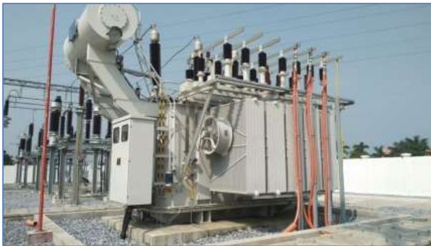
Hình 1.1 Máy biến áp 3 pha
