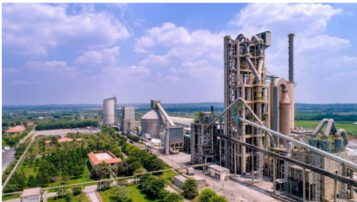
Hình 1.1 Nhà máy xi măng
