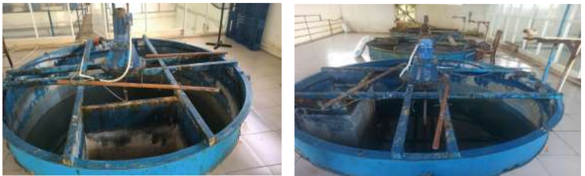
Hình 2.7 Các thiết bị bị ăn mòn do hóa chất PAC
