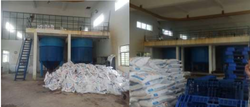
Hình 2.6 Khu vực 2 bể pha hóa chất và 3 bể pha hóa chất
