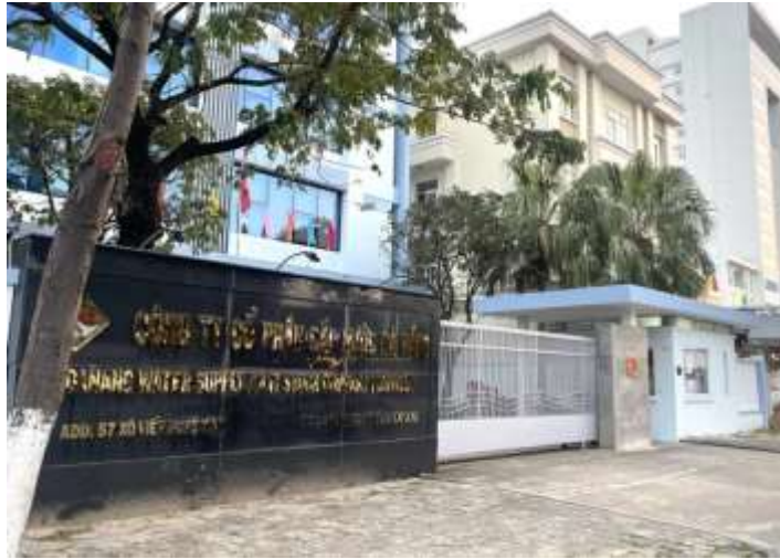
Hình 2.1 Công ty cổ phần cấp nước Đà Nẵng
