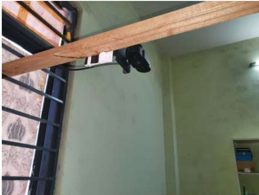
Hình 4.16: Thi công giá đỡ lắp đặt camera
