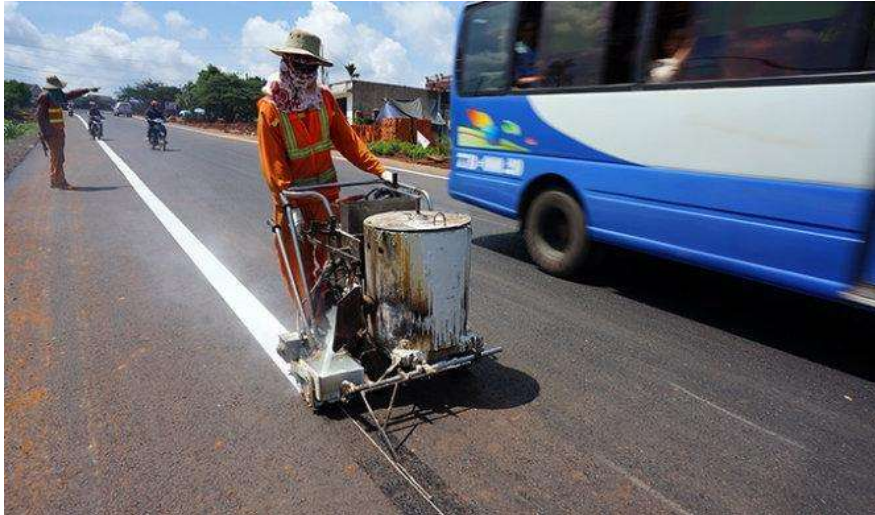
Hình 1.1. Kẻ vạch đường thủ công
