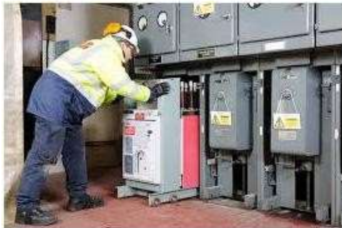
Hình 3.1 . Kỹ sư đang kiểm tra bằng cách đo thủ công máy cắt trung áp hợp bộ
