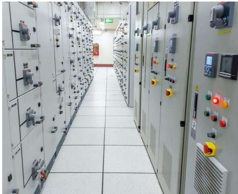
Hình 1.1. Máy cắt hợp bộ trung áp trong nhà máy
