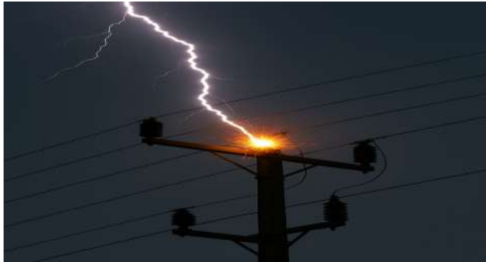
Hình 1.4: Hình ảnh phóng điện do sét đánh trên đường dây
