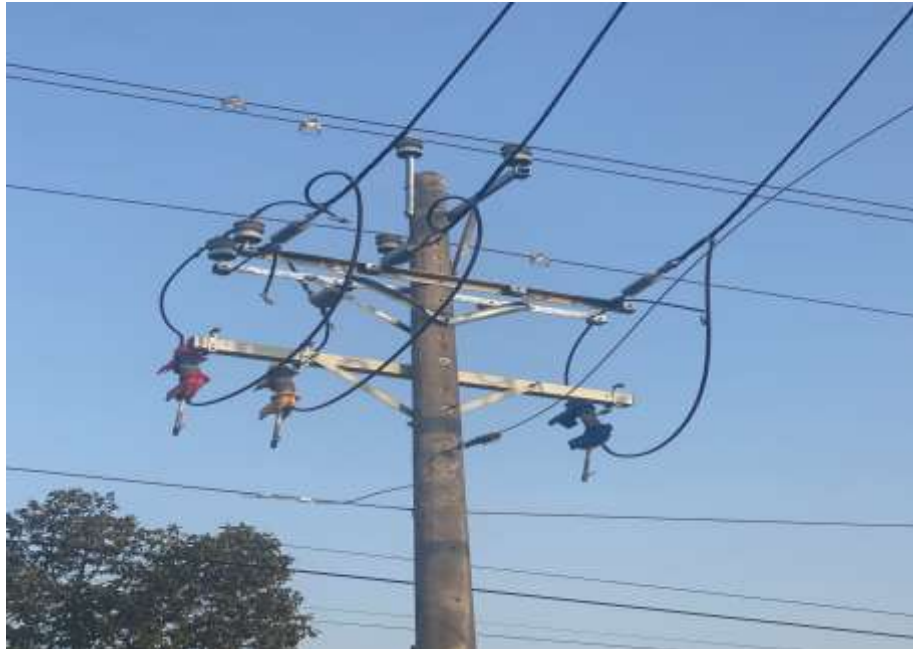
Hình 2.1: Mô hình lắp đặt DCS trên lưới điện trung thế 22kV
