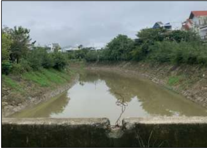
HÌNH 1. 9. TUYẾN KÊNH TRƯỚC HỒ HÒA PHÚ
