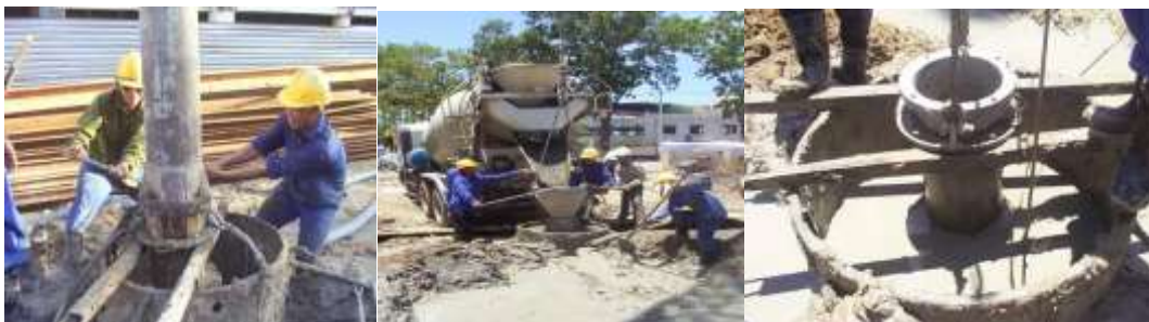
Hình 5.5. Hình ảnh thực tế thi công
