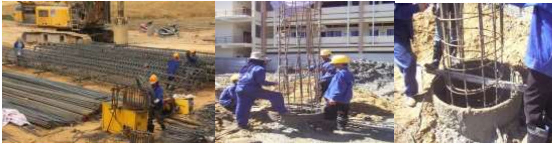
Hình 5.3. Công tác gia công lắp đặt và hạ lồng thép
