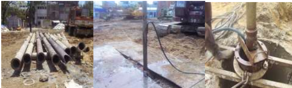
Hình 5.4. Ống Trime, ống thổi rửa và lắp đặt ống thổi rửa hố khoan
