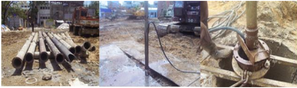
Hình 2.7 Ống Tremie, ống thổi rửa và lắp ống thổi rửa hố khoan
