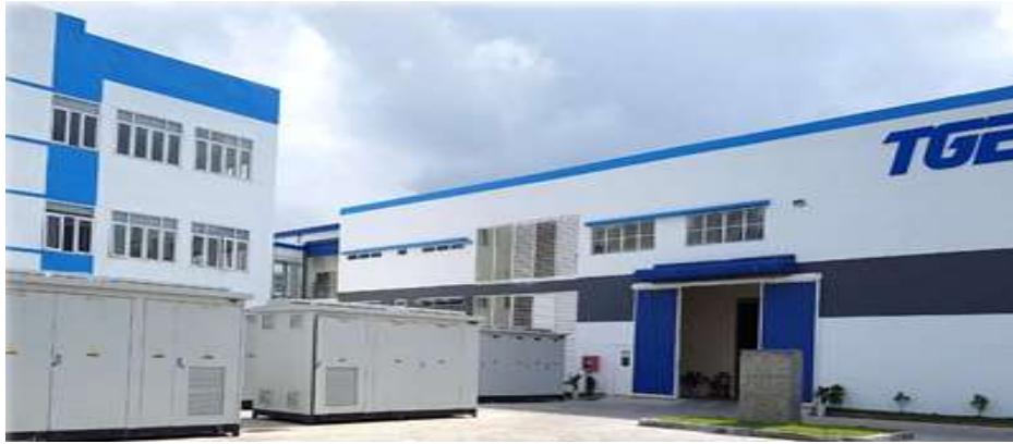
Hình 3.6: Trạm hợp bộ
