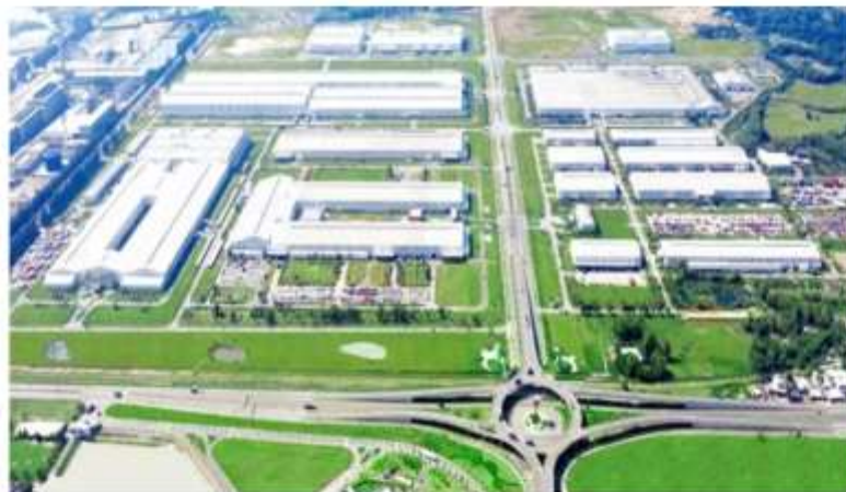
Hình 5: Khu công nghiệp THACO Chu Lai
