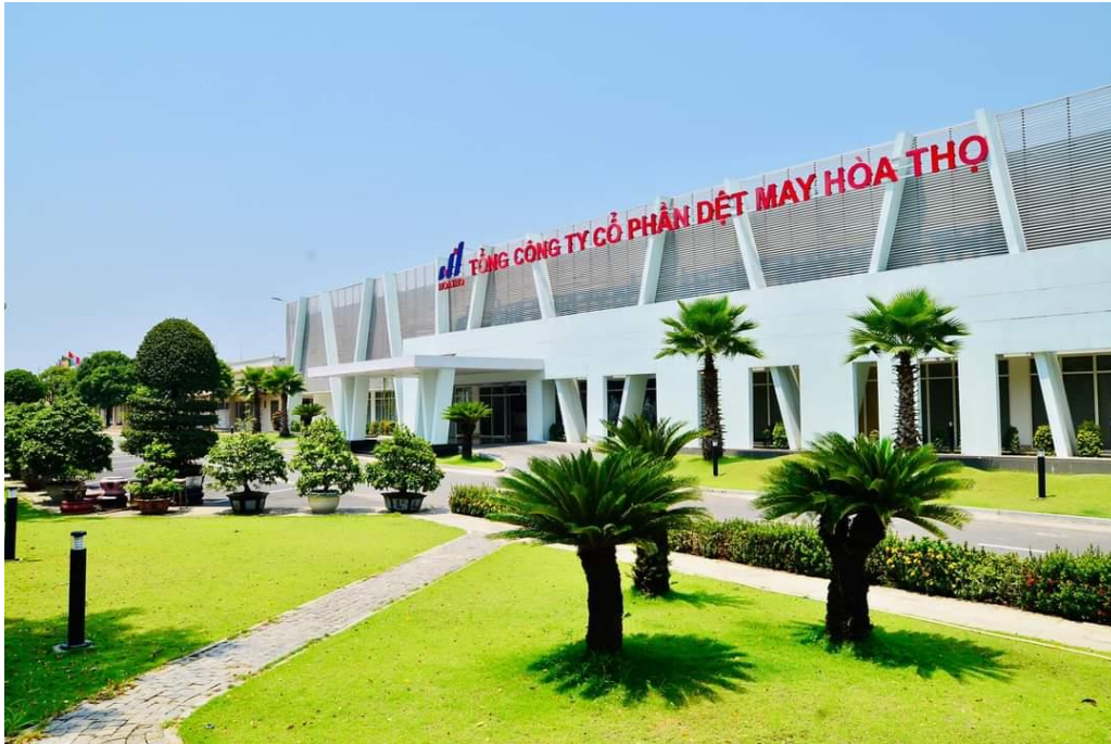
Hình 2: Tổng công ty Cổ phần dệt may Hòa Thọ
