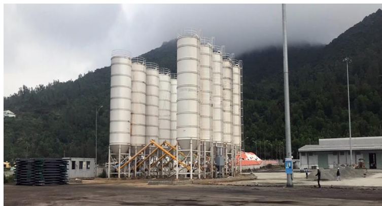
Hình 3.6: Chế tạo và lắp đặt Silo chứa xi măng 230 tấn tại cảng Liên Chiểu
