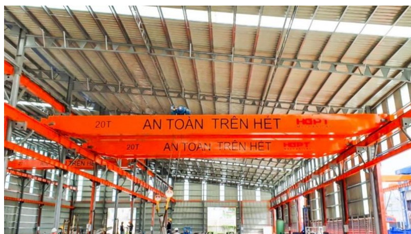
Hình 3.4: Kết cấu cầu trục tại xưởng HGPT
