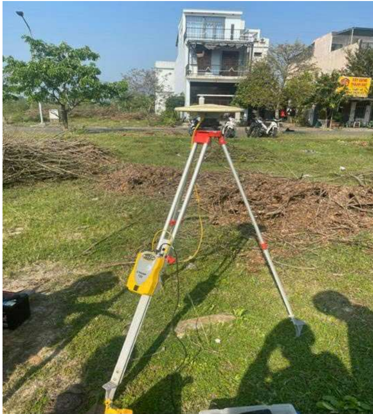
Hình 2.3: Nhóm lắp đặt và thiết lập trạm Base
