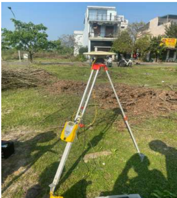
Hình 2.2: Công tác thiết lập trạm gốc
