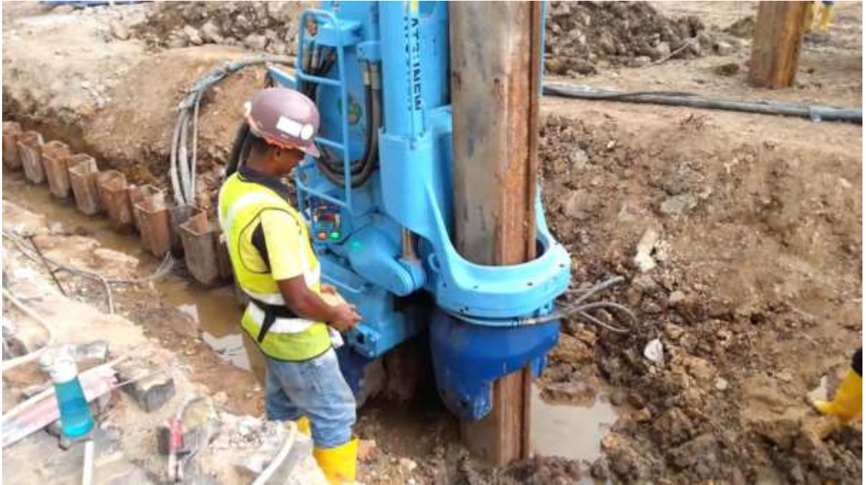
Hình 2.18: Phương pháp ép cừ bằng búa rung
