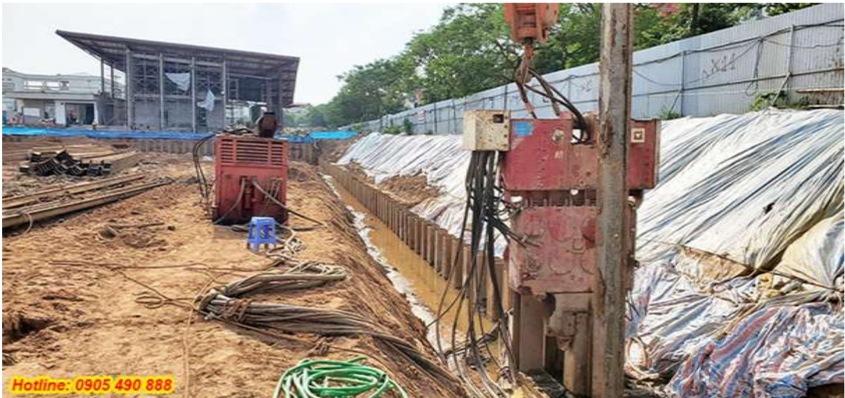
Hình 2.17: Phương pháp ép cừ bằng máy ép tĩnh
