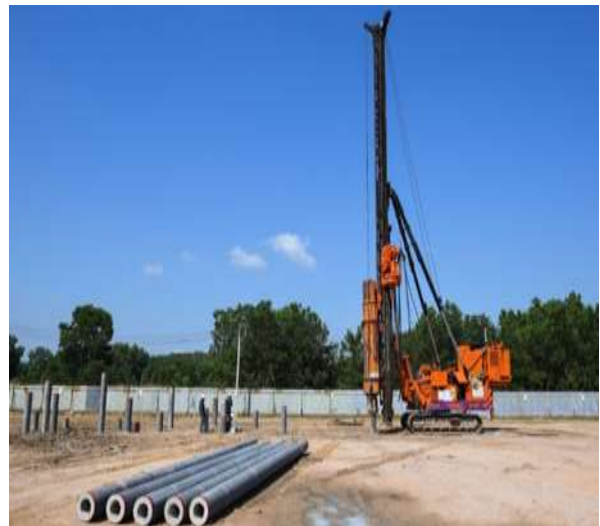
Hình 2.8: Phương pháp ép cọc trước và ép cọc sau
