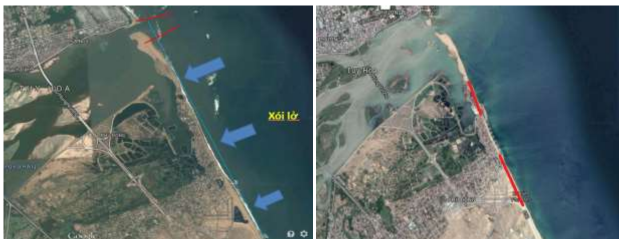
Hình 3.2 Hiện trạng khu vực xây dựng tuyến kè
