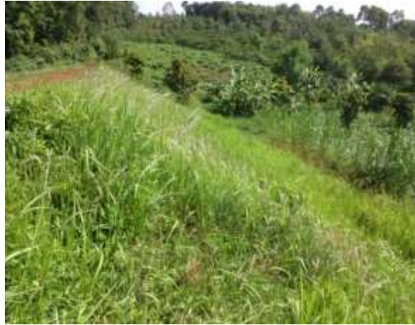
Hình 2.4. Mái đập hạ lưu
