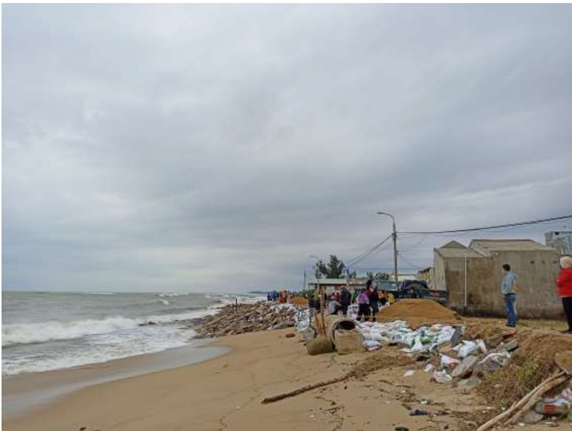
Hình 2.4. Hiện trạng hư hỏng khu vực thiết kế
