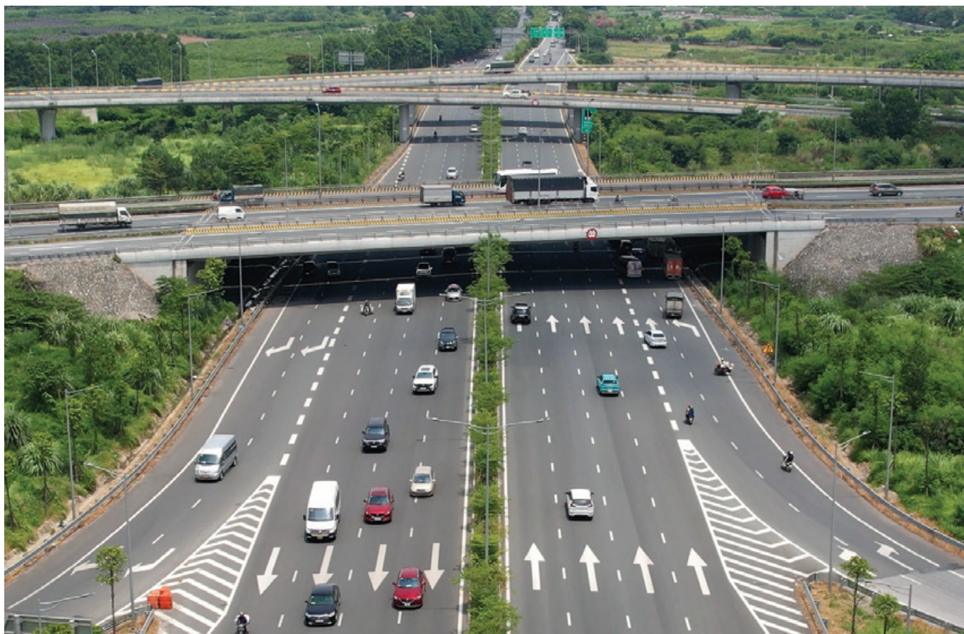
Nhiều giải pháp công nghệ hiện đại đã được áp dụng thi công đường cao tốc Hà Nội - Hải Phòng.
