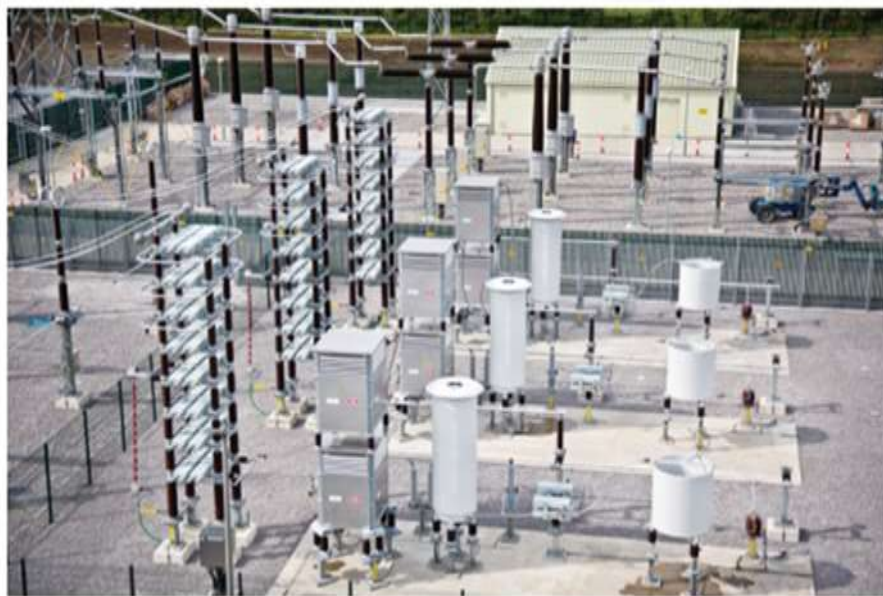
Hình 2. 19 Bộ lọc AC tại trạm HVDC Light Woodland. Liên kết Đông - Tây, Ireland. (Ảnh do ABB cung cấp.)
