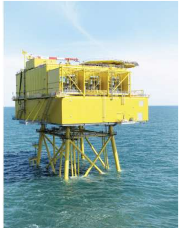
Hình 2. 22 Trạm chuyển đổi VSC- HVDC ngoài khơi Borwin.
