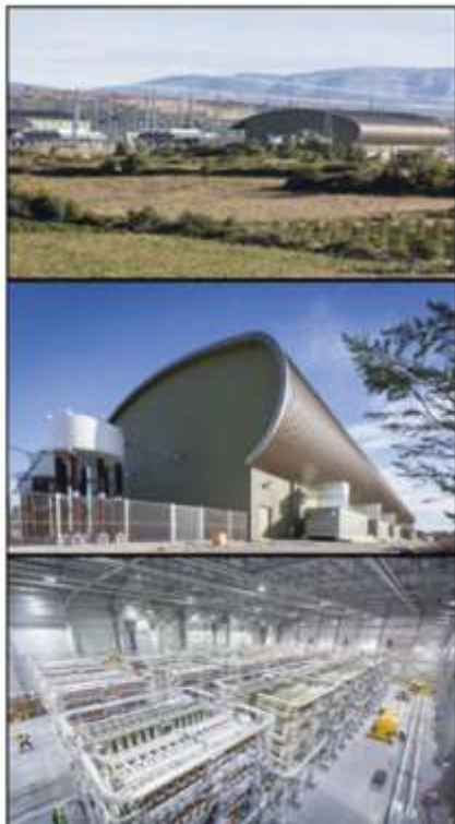
Hình 2. 21 Trạm chuyển đổi dự án INELFE
