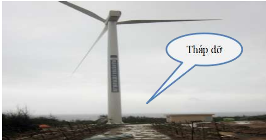
Hình 1.11: Tháp đỡ hình trụ của tuabin gió.
