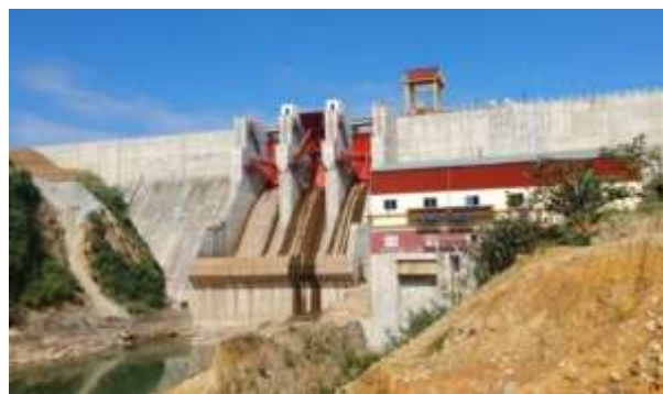
Hình 1.4 Hình ảnh Nhà máy Thủy điện Rào Trăng 4
