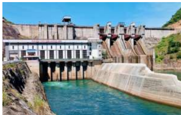
Hình 1.7 Hình ảnh Nhà máy Thủy điện Hương Điền
