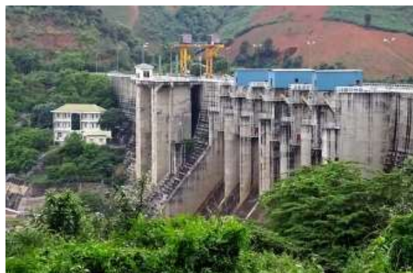
Hình 1.29 Hình ảnh Nhà máy Thủy điện Đăk Po Ko
