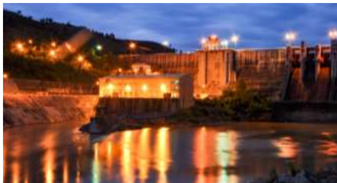
Hình 1.21 Hình ảnh Nhà máy Thủy điện Pleikrông
