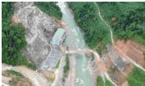
Hình 1.3. Hình ảnh Nhà máy Thủy điện Rào Trăng 3
