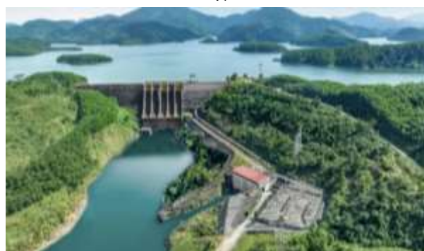
Hình 1.8 Hình ảnh Nhà máy Thủy điện Bình Điền
