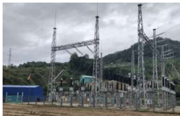
Hình 1.12 Hình ảnh Nhà máy Thủy điện Ken Lút Hạ
