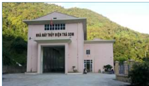
Hình 1.11 Hình ảnh Nhà máy Thủy điện Trà Xom
