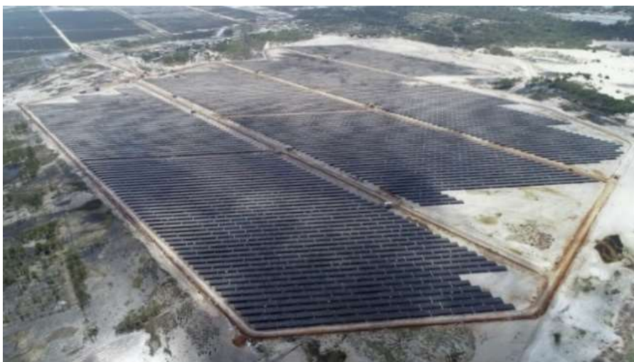
Hình 1.35 Hình ảnh Nhà máy Điện mặt trời Gio Thành 1
