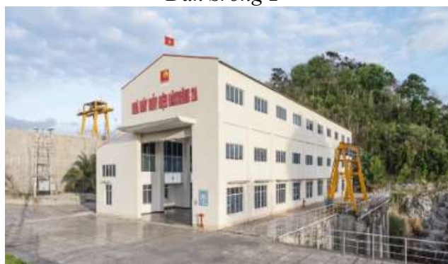
Hình 1.15 Hình ảnh Nhà máy Thủy điện Đắk Srông 2A
