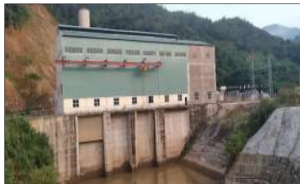
Hình 1.27 Hình ảnh Nhà máy Thủy điện Đăk Psi 2B
