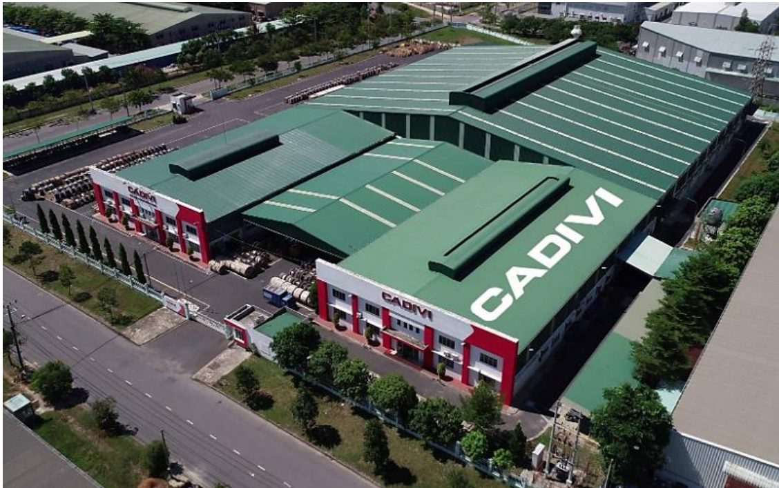
Hình 3-2 Nhà máy CADIVI Đà Nẵng
