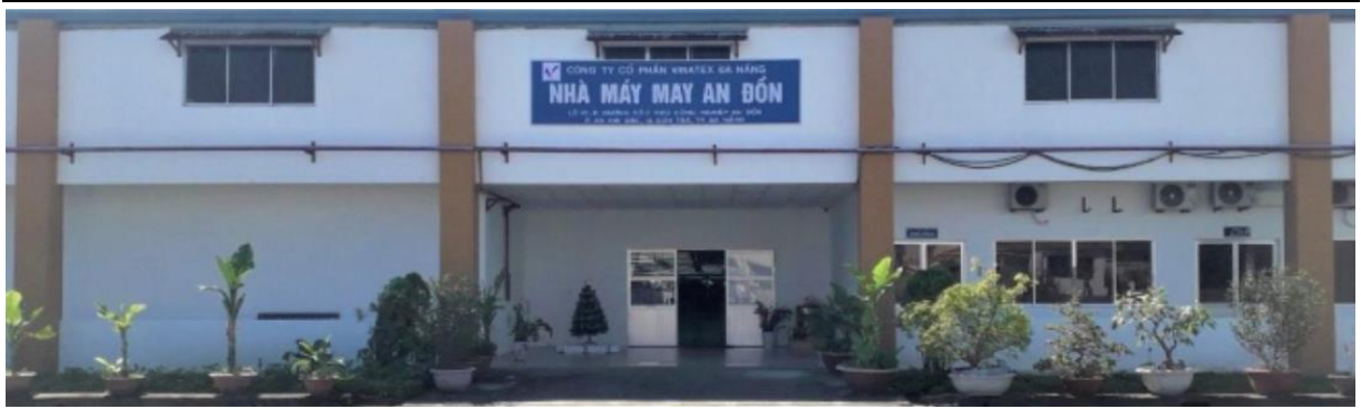
Hình 1.2 Nhà máy may An Đồn Đà Nẵng
